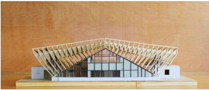
【連続するトラス】平面トラスが徐々に角度を変えながら曲面屋根を構成
